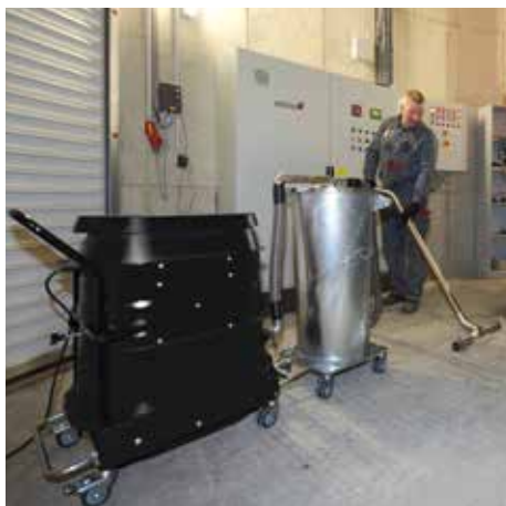
R01 A020 z separatorem wstępnym w elektrociepłowni
